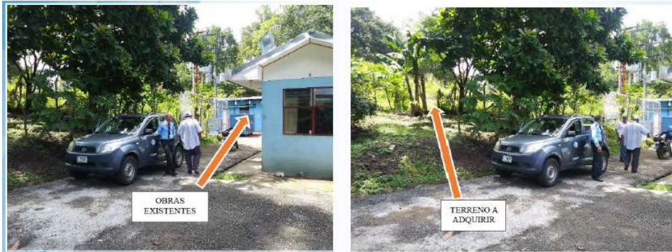
Caseta de bombeo
