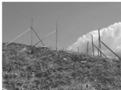
Fotografía 22. Colocación de mallas para atrapar restos de basura por acción del viento.
