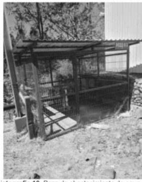
Fotografía 10. Pozo de abastecimiento de agua #2
