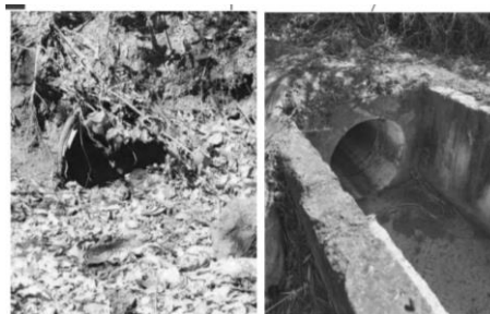
Fotografías 11 y 12. Salidas de canalización pluvial hacia el Río Virilla.
