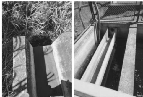
Fotografías 16 y 17. Vertido (izquierda) de forma directa desde los sedimentadores (derecha)
