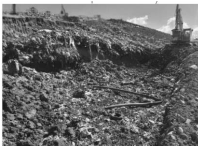
Fotografía 23. Labores de excavación en celdas para instalación de pozos de captación de lixiviados.
