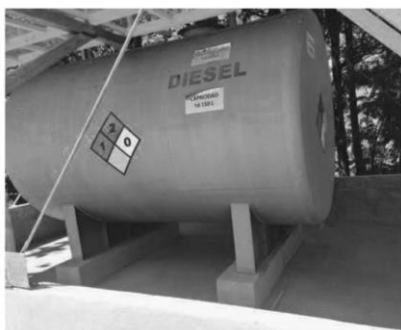
Fotografía 4. Área de almacenamiento de diésel limpia y sin fugas.
