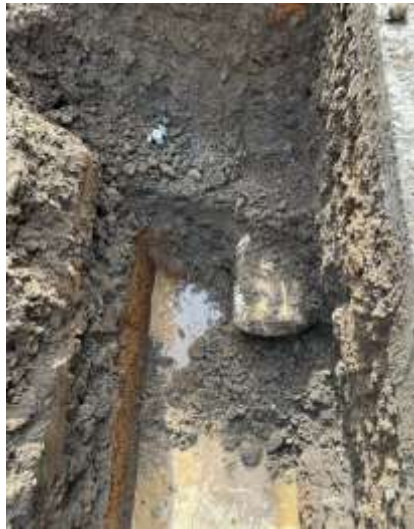
2. Excavación, colocación de tubería y relleno
