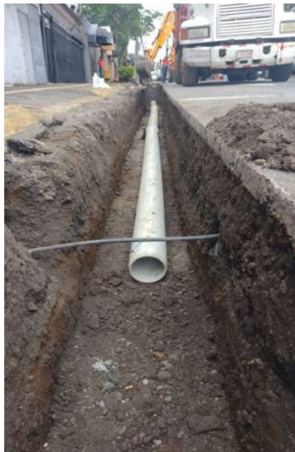
Fotografías Cambio de Tubería de Asbesto
