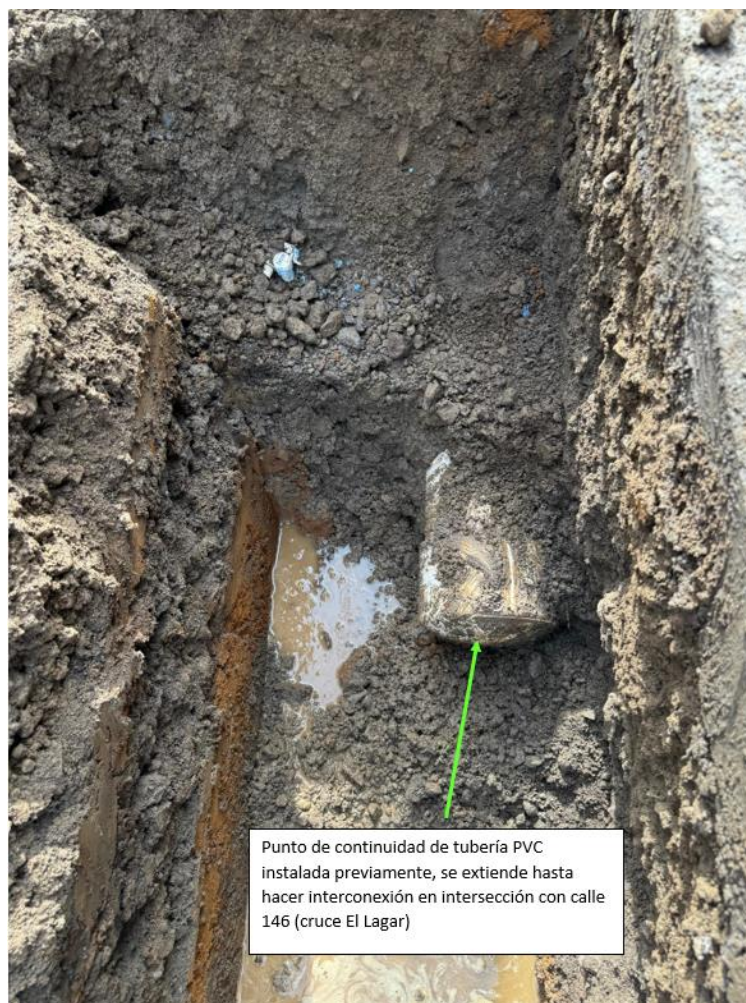
PUNTO DE CONTINUIDAD DE TUBERÍA PVC DE 8" SOBRE RUTA NACIONAL 111
