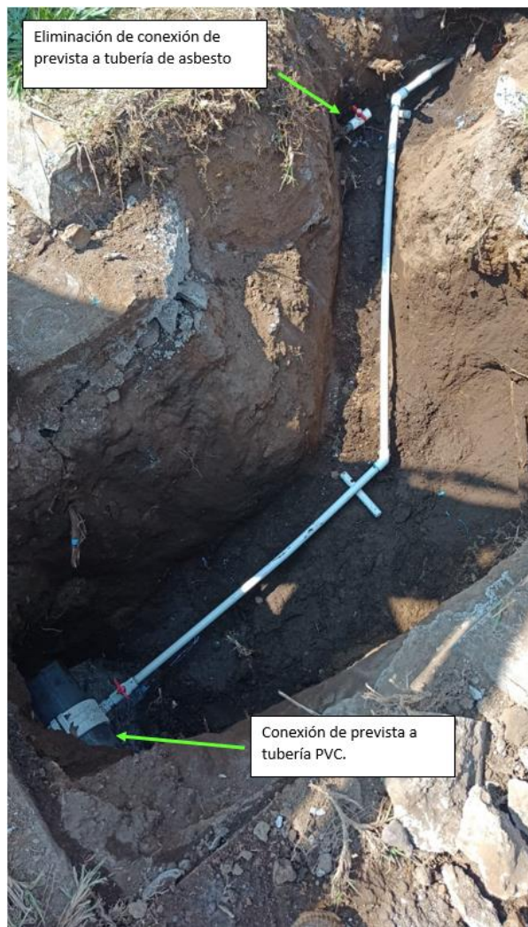
TRASLADO DE PREVISTAS A TUBERÍA PVC
