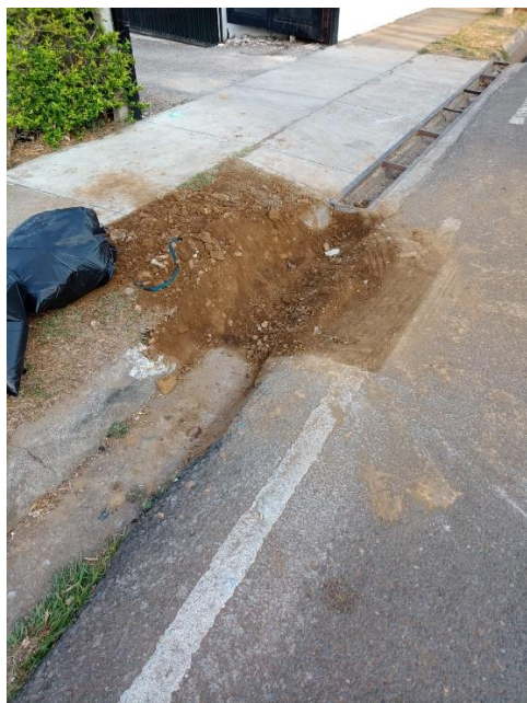
RELLENO DE ZANJAS PARA POSTERIOR REPARACIÓN DE CORDON DE CAÑO Y BACHEO
