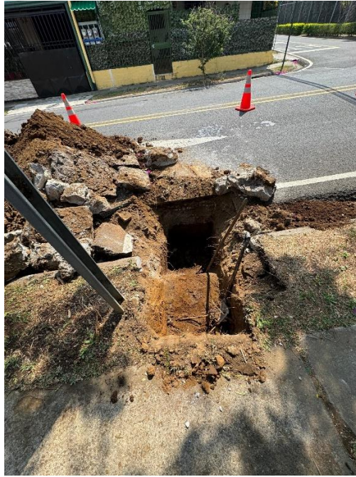
EXCAVACIÓN PARA REALIZAR TRASLADO DE PREVISTAS A TUBERÍA DE PVC
