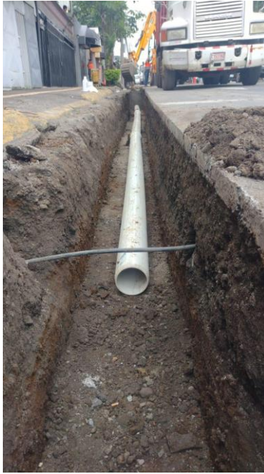
CONTINUACIÓN DE TUBERÍA PVC DE 8" SOBRE RUTA NACIONAL 111.
