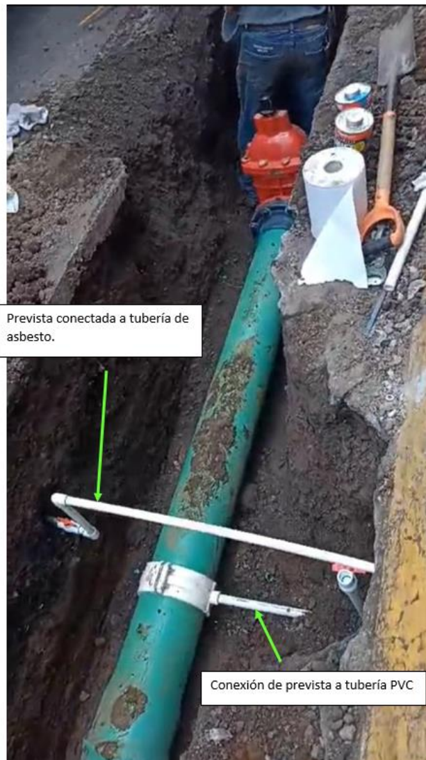
TRASLADO DE PREVISTAS A TUBERÍA PVC
