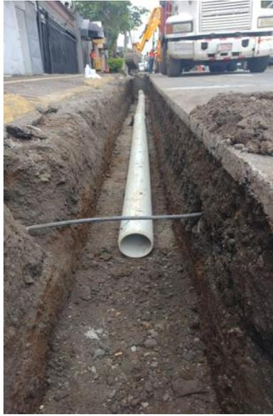
Fotografías Cambio de Tubería de Asbesto
