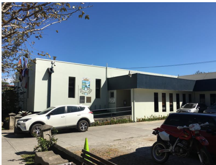
Fotografía N°1. Edificio Principal de la Municipalidad de Belén. 2018.
