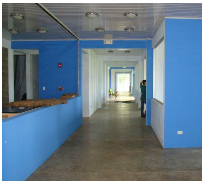
Fotografía N°6. Biblioteca Municipal. Edificio Nuevo. 2018.
