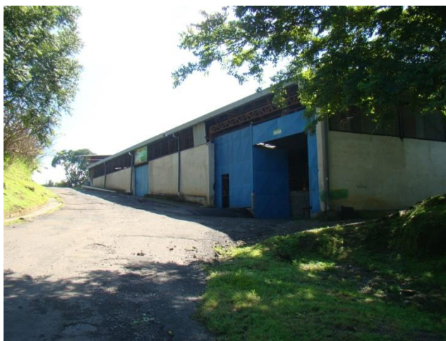
Fotografía N°8. Bodegas Municipales. Municipalidad de Belén. 2018.
