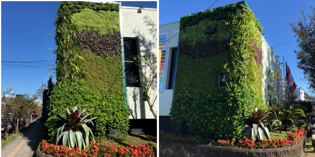
Figuras N°76 y 77. Jardín vertical del Edificio Principal. 2021.
