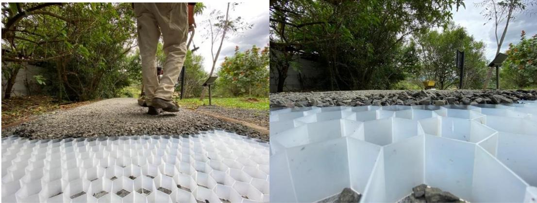
**Figura N°43 y 44. Senderos con grava estabilizada para filtración de escorrentía. 2020.**
