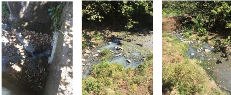
Cabezal de desfogue a canal y aguas provenientes del sistema municipal. Fotografía del 11 de enero de 2020. Nota presentada a la municipalidad en enero 2020.
