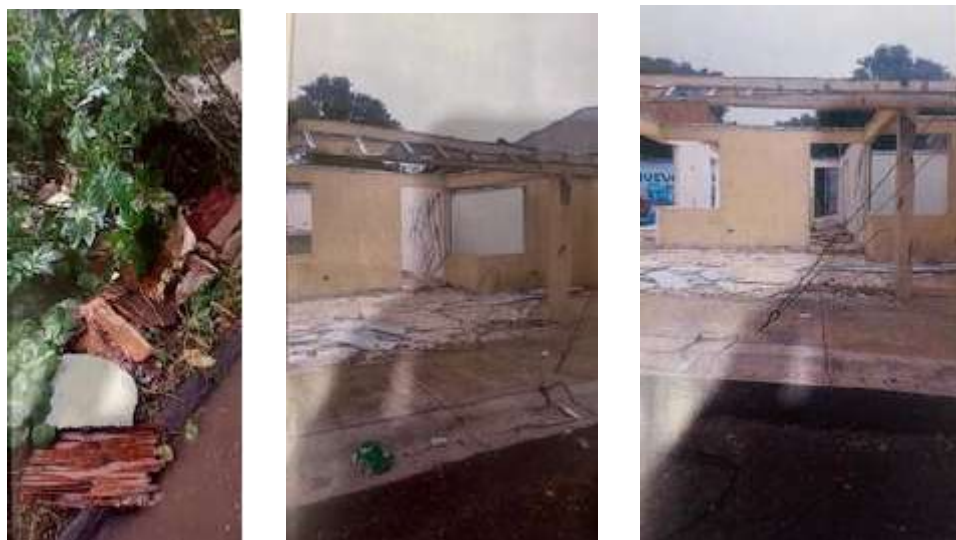
Trámite 2558-2024 – Alcantarilla y acera en mal estado en la esquina de la tienda Chayfer.
