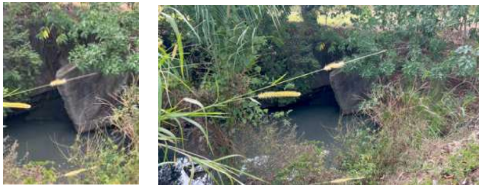
Cabecal de desfogue a canal y aguas provenientes del sistema municipal. Fotografía del 22 de abril de 2025.
