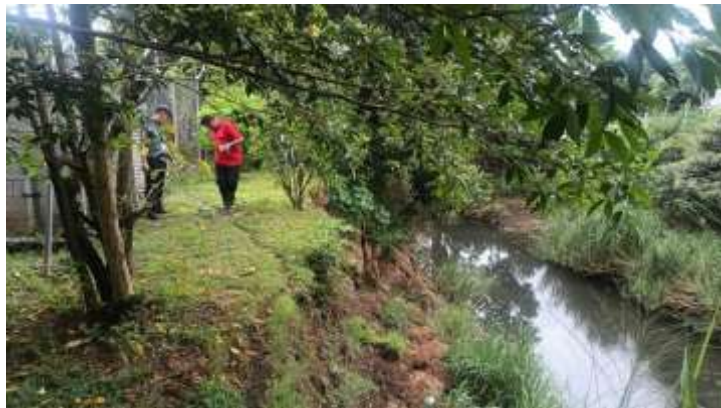
Fotografía 2. Vista lateral izquierda: detalle del talud con erosión activa.
