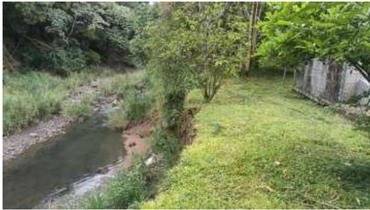
Fotografía # 1. Vista lateral derecha. Se aprecia la cercanía de la planta con el cauce y la reducción de la franja de protección.
