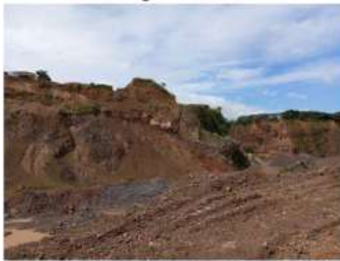
Fotografía 1. Trabajos de estabilización realizados
