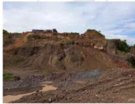
Fotografía 2. Trabajos de estabilización realizados
