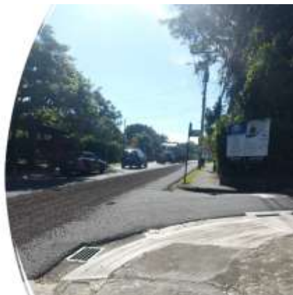
13/08/2025 08:12hrs Vagoneta de pedregal a alta velocidad desborda material desde el primer reductor hasta tercer reductor
