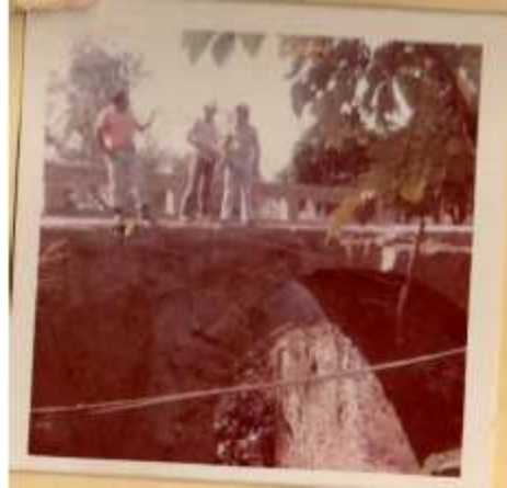
El sr Asdrúbal Molina, Maestro de Obras del MOPT, fue el que realizó varias obras en el Cantón de Belén. en esta fotografía aparece, el Sr Asdrúbal al lado derecho, Feliz zumbado Arrieta y Juan Luis Villegas Villalobos. en la reparación del puente de arco del barrio San Vicente. año 1973
