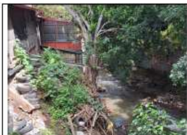
Figura 2 En la parte trasera de las propiedades hay una ladera que limita con la Quebrada Seca
