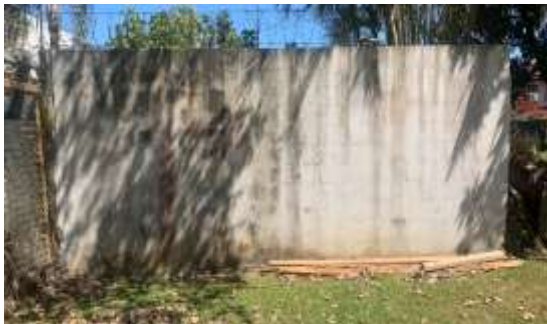
Tapias construidas en el Parque
