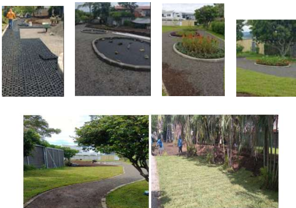
Construcción de acceso y enzacatado Parque Bloque H
