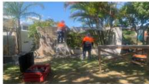
Tapias en proceso de demolición
