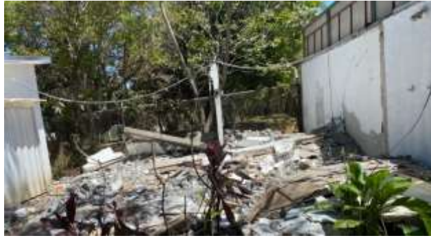
Demolición en proceso de apartamentos
