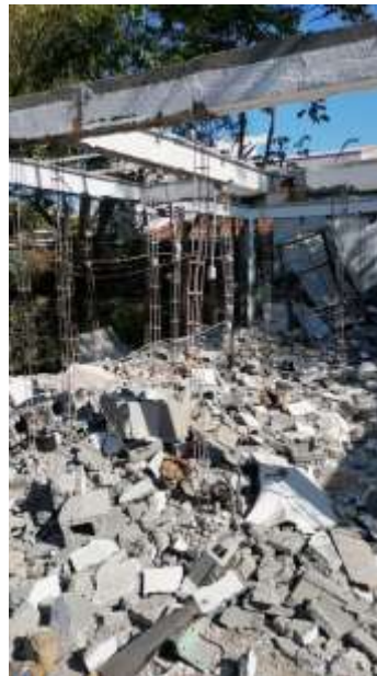
Demolición en proceso de apartamentos
