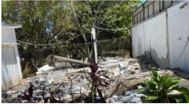
Demolición en proceso de apartamentos
