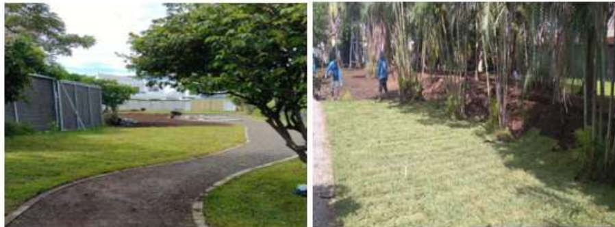
Construcción de acceso y enzacatado Parque Bloque H
