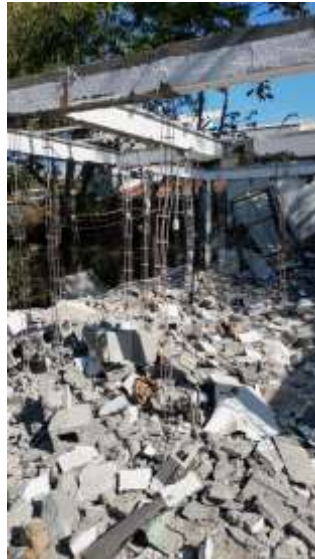
Demolición en proceso de apartamentos
