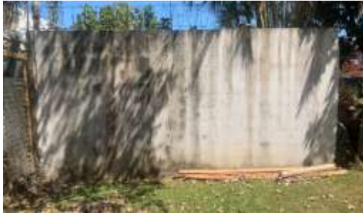
Tapias construidas en el Parque
