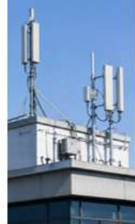
Edificios y/o sus Azoteas
