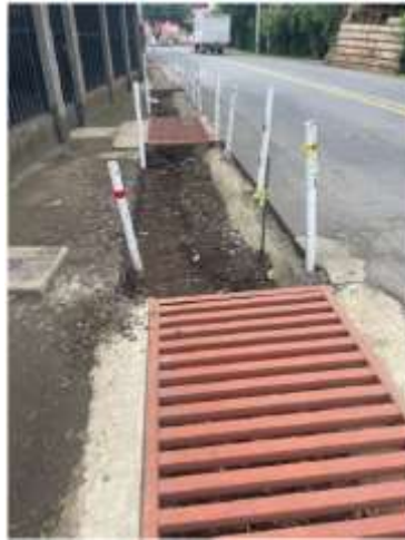
Estado actual Ruta Nacional N.º 111 Sector La Casona del Pollo
