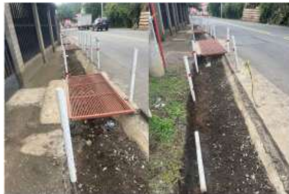
Estado actual Ruta Nacional N.º 111 Sector La Casona del Pollo
