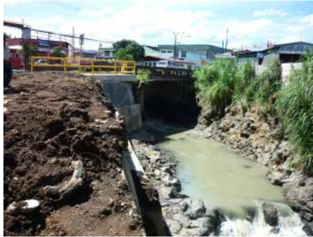
hacia aguas abajo puente Cachón
