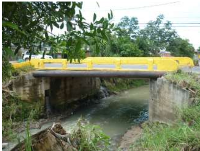
Vista hacia aguas arriba del puente de la Ruta 111
