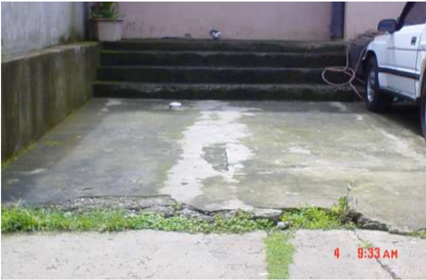
■ Descarga de Aguas Residuales crudas sobre acera y zonas verdes y a cuneta.
