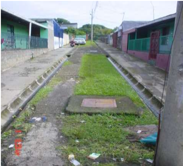
- Descarga de Aguas Jabonosas a cuneta y a tragante del Alcantarillado Pluvial. Se evidencia color verde del algas microscópicas.
