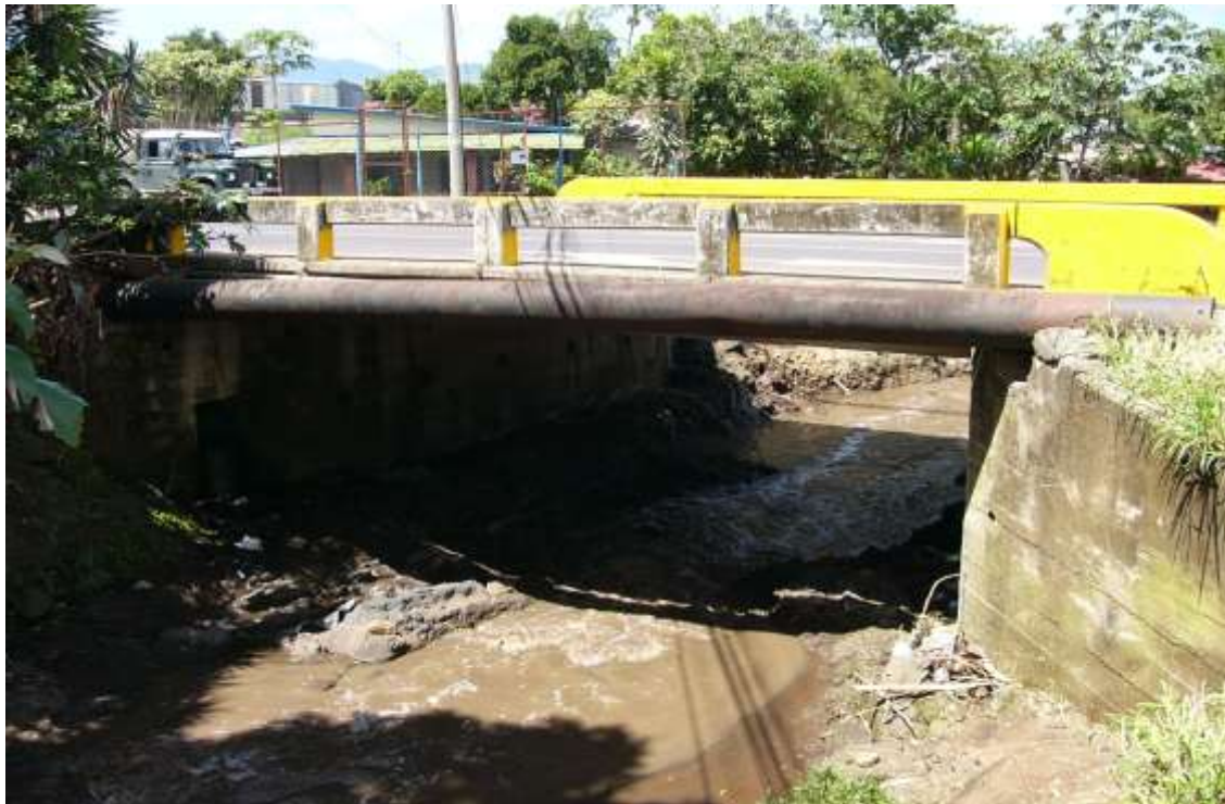
Puente N° 7 Ruta nacional 122, carretera a San Rafael de Alajuela.
