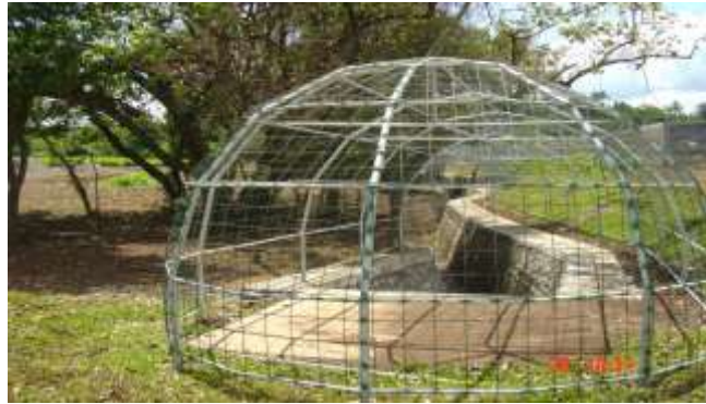
Fotografía N a 2: Se puede observar la estructura de concreto que se desarrollo a los lados del yurro y la estructura de metal alrededor.
