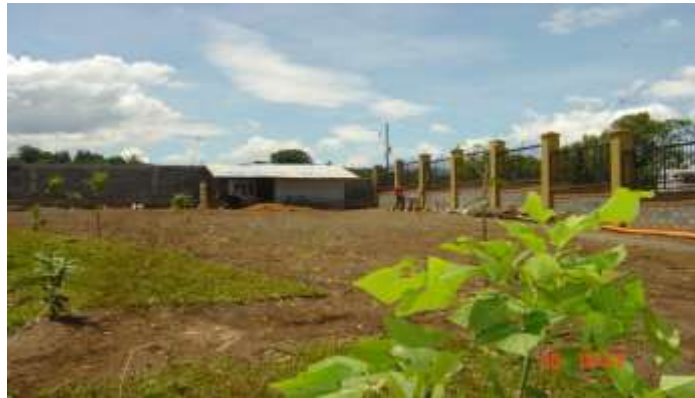
Fotografía N a 3: Vista panorámica del sector del yurro y del muro de concreto el cual lo separa del resto del proyecto.
