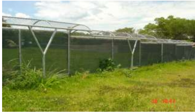
Fotografía N° 5: Sector donde existe la separación del Humedal y la zona del parque infantil. Se puede ver la falta de arborización y se siembra de enredaderas en la malla.
