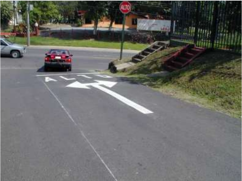
Foto N° 3 : Señalamiento Vial en la Calle Zumbado
