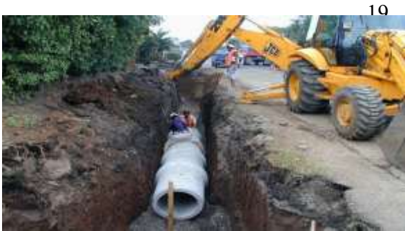
Foto N° 1 : Alcantarillado sobre Ruta 111, costado norte, de la entrada a Calle Scott hacia el este.
