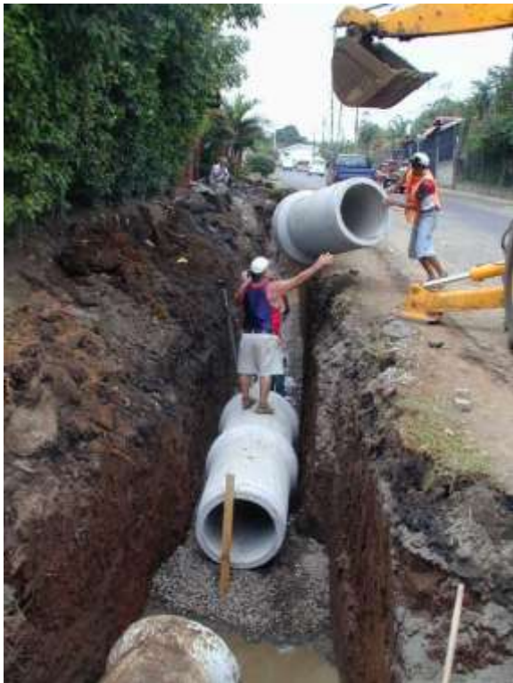
Foto N° 2 : Colocación de tubería, proyecto ejecutado en conjunto con la Asociación de Desarrollo Integral de La Asunción.
