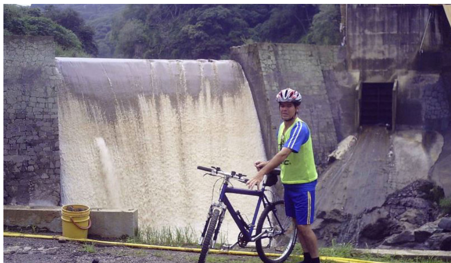
Puente Mulas también ha sido un lugar atractivo para ciclistas, corredores y caminantes. Fotografía suministrada por Giovanni Ortiz/2010
