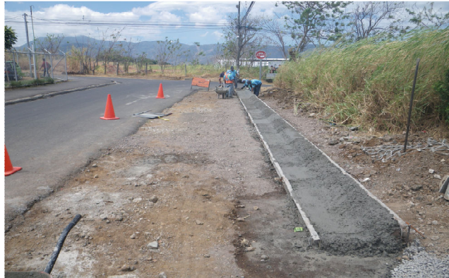
Cordón y Caño en Construcción
