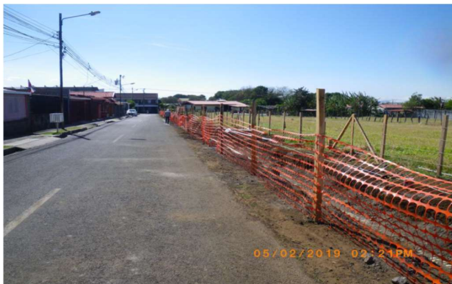
Zona de trabajo delimitada.
